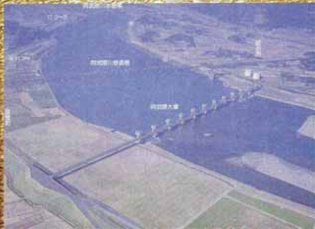
～阿武隈大堰全景～
