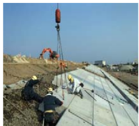
堤防保護のコンクリート設置状況
