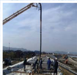
堤防天端をコンクリートでの打設状況
