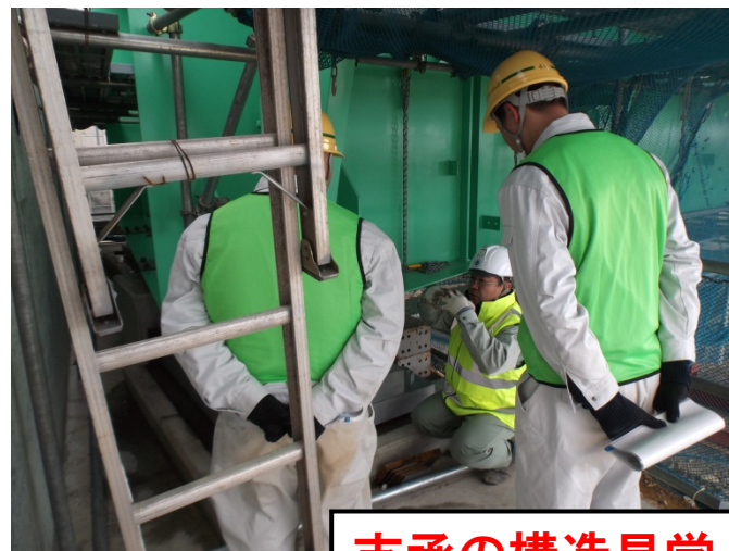
支承の構造見学
