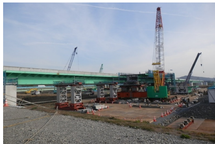
▲矢本石巻道路(新天王橋)の4車線化工事状況
