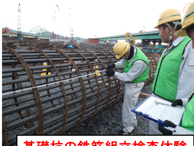
基礎杭の鉄筋組立検査体験
