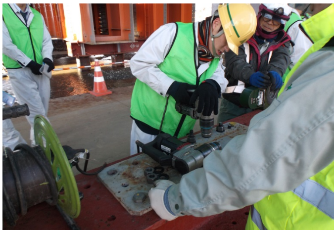
高力ボルトの締め付け体験
