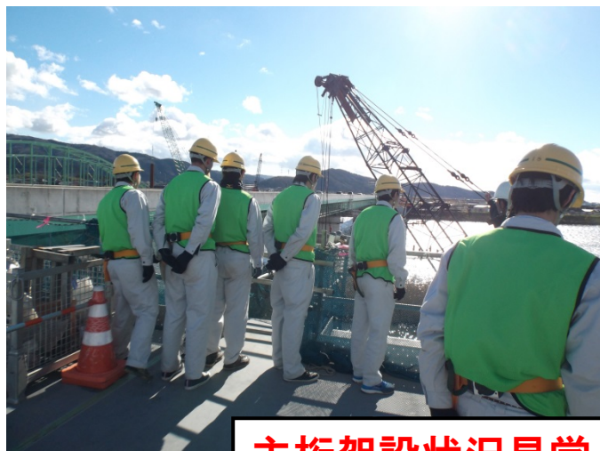
主桁架設状況見学
