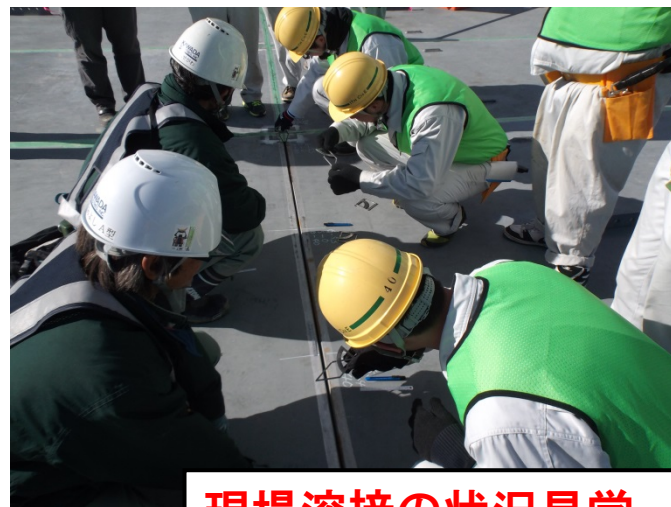
現場溶接の状況見学
