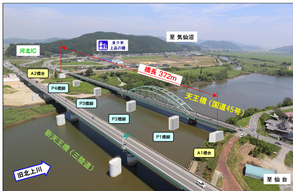
▲ 国道45号 天王橋の架替え
