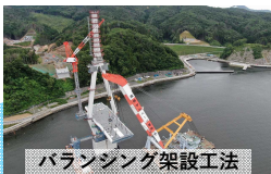
バラシング架設工法
