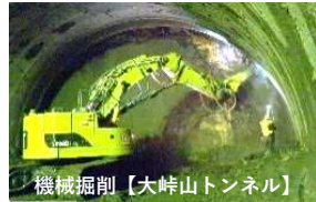
機械掘削【大峠山トンネル】
