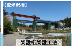
架設桁架設工法
