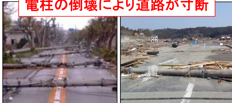
▲ 台風や地震等による電柱の倒壊
