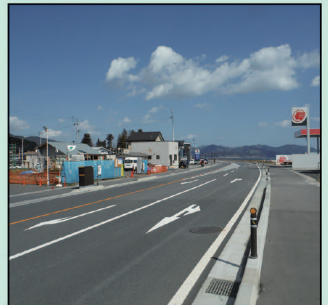
▲電線共同溝完了箇所 (R1年度 吉里吉里地区)
