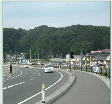
▲電線共同溝完了箇所 (H30年度 宮古市田老地区)
