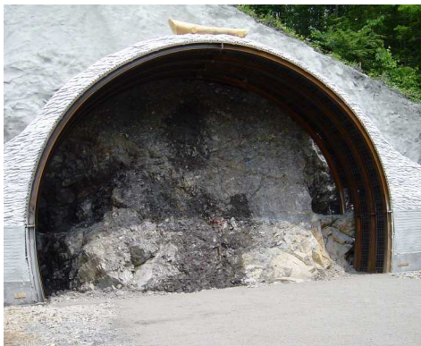
これから工事が行われる 大牛内トンネル坑口
