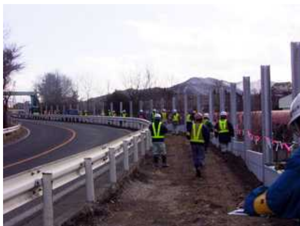
現場パトロールの様子
