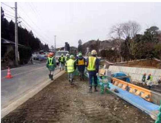
現場パトロールの様子(久慈地区歩道工事)
