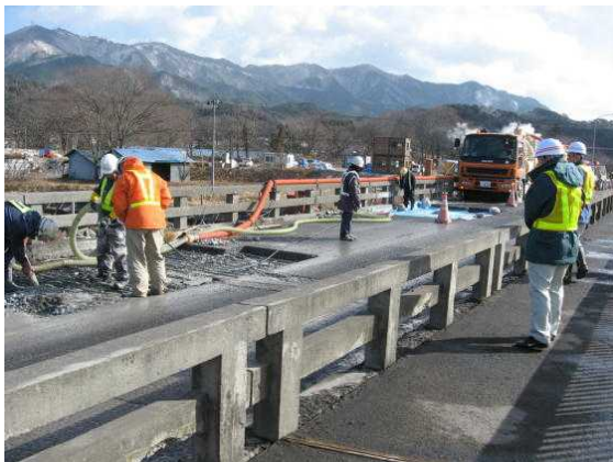
「新田橋補修工事」現場点検状況
