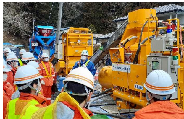
▲全自動でモルタルを吹付するシステムの説明
