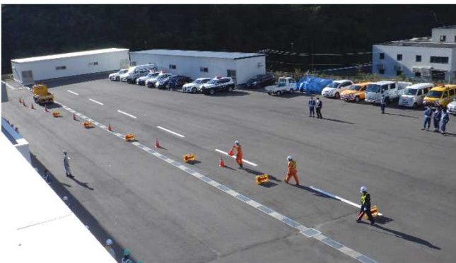
▲ 道路維持業者（刈屋建設）
