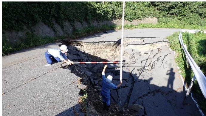
▲ 現地計測状況
