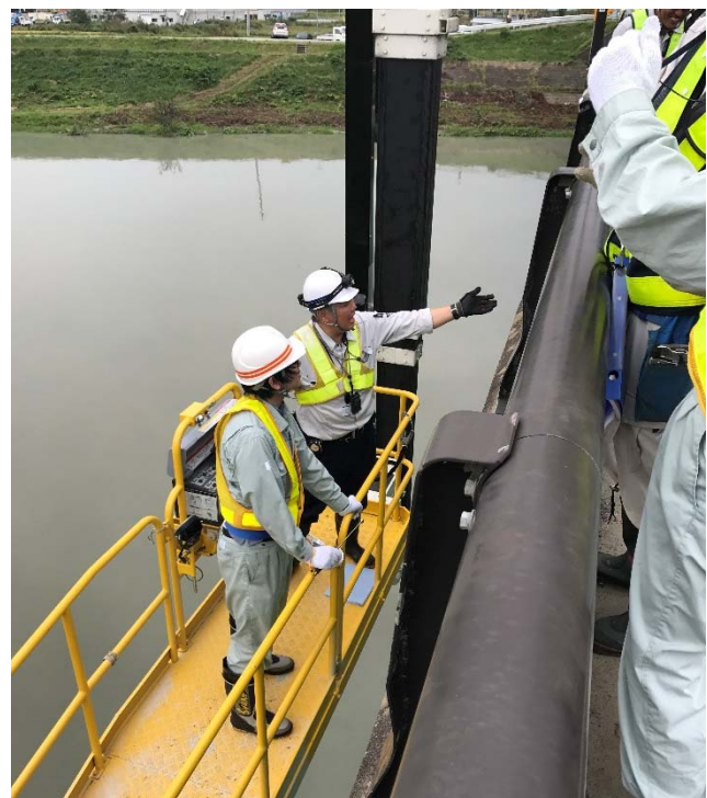
点検車に乗り、主桁の損傷状況の説明を受ける若手職員
