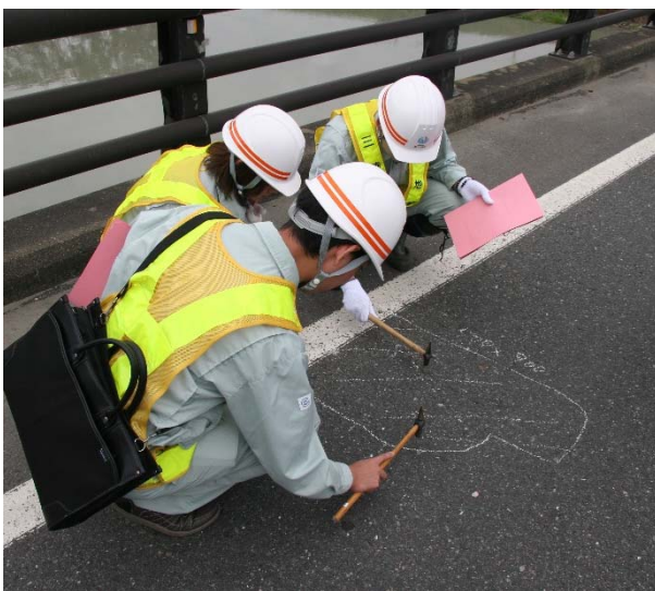
橋面の損傷状況を確認する若手職員
