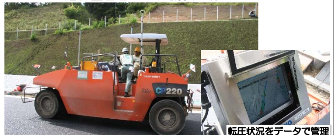
転圧状況をデータで管理
