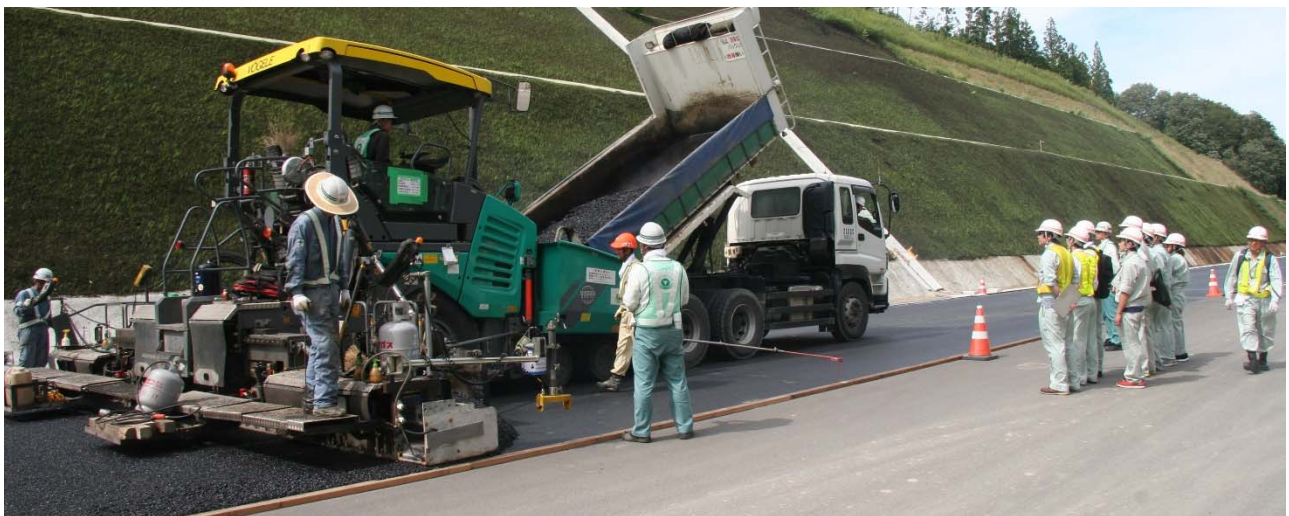
アスファルト舗装現場を見学する若手職員
