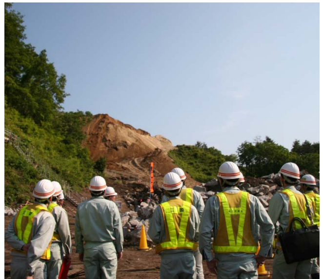
切土の施工現場を見学する若手職員
