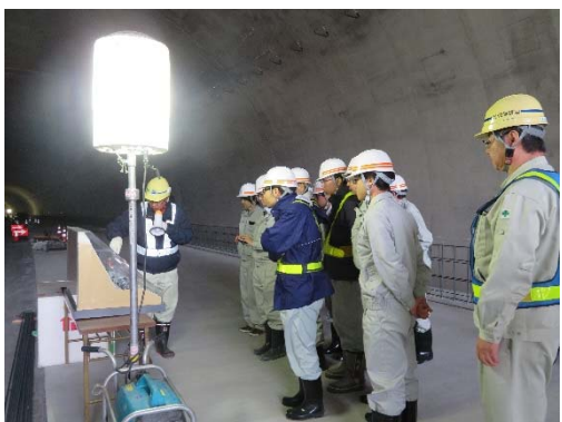
▲施工業者の説明を聞く若手職員
