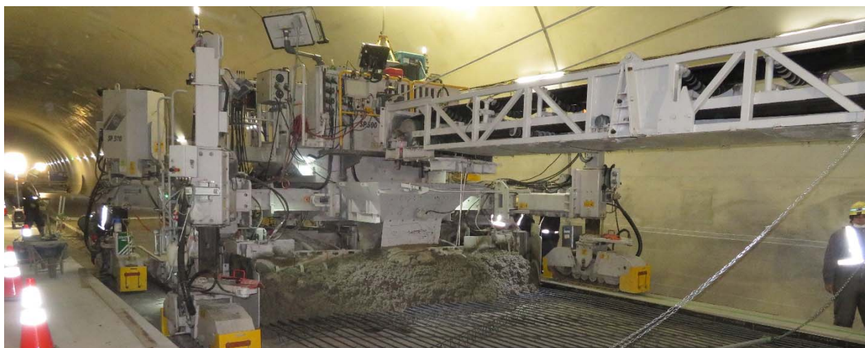
山田宮古道路（仮称）山田第一トンネル スリップフォーム工法による、コンクリート舗装の様子
