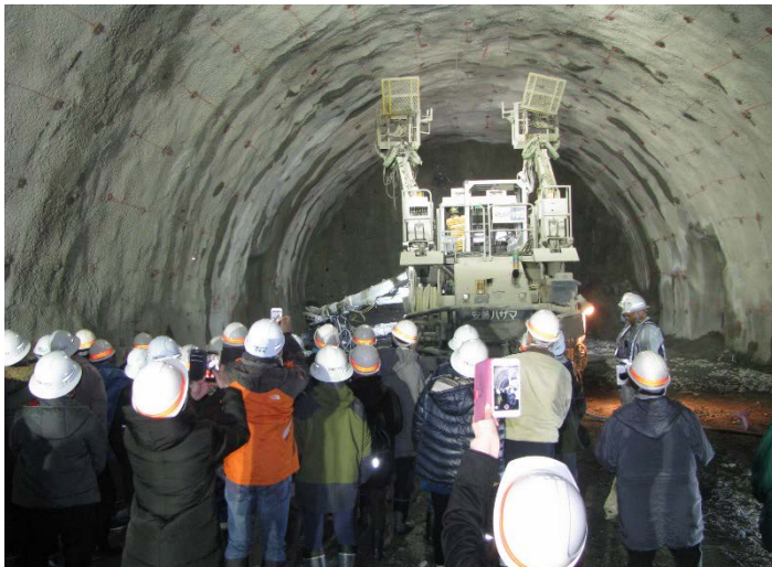
▲ドリルジャンボによる削孔状況の見学
