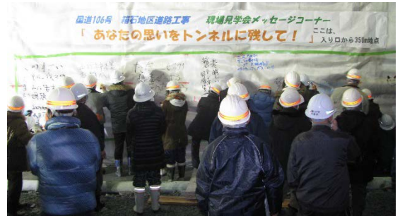
▲壁面（防水シート）に記念のサイン
