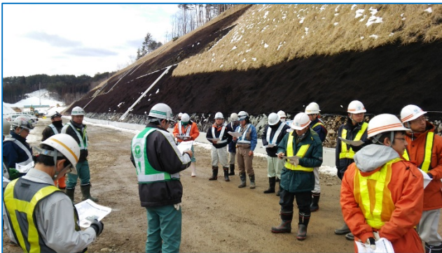
工事内容や安全対策について参加者に説明
