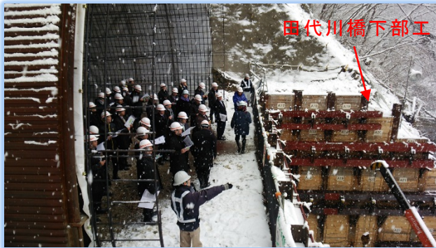
下部工（深礎杭）の施工では、岩盤掘削のためダイナマイトを使用しています。
