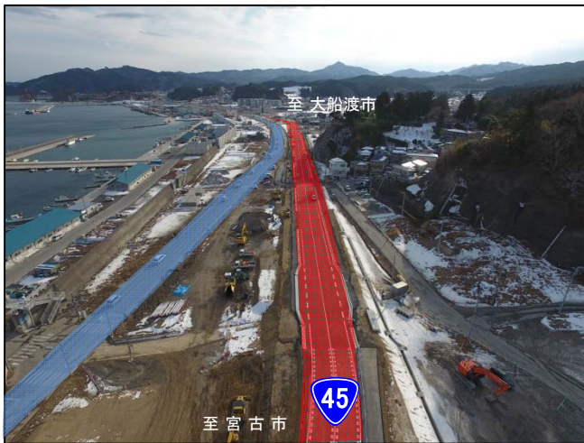
▲国道かさ上げ後の状況 (平成29年2月5日)
