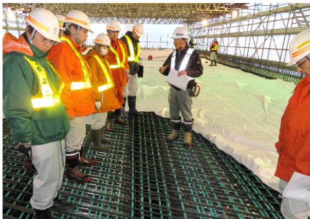
エポキシ樹脂被服鉄筋について 説明を聞く参加者
