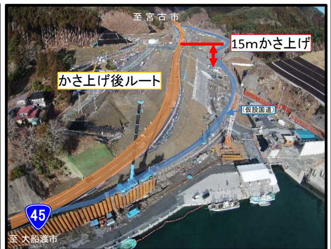
▲国道かさ上げ後の状況 (平成29年1月31日)
