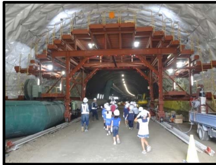
トンネル坑内見学の様子
