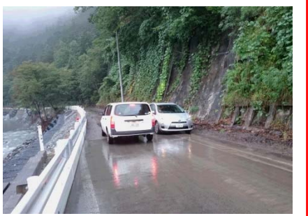
一般車通行状況(9/23)
