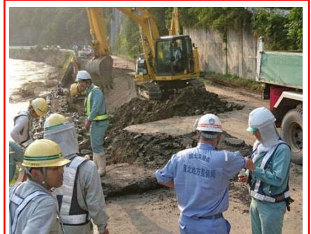
復旧作業状況(9/1)
