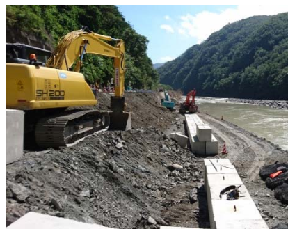
復旧作業状況(9/5)
