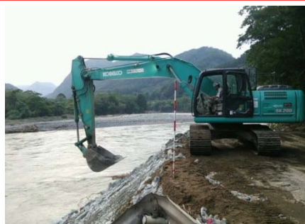
復旧作業状況（9/1）
