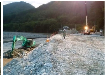
復旧作業状況（9/5）
