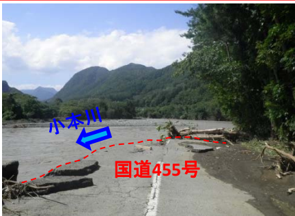
復旧作業着手前（8/31）
