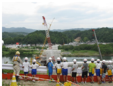
（仮）閉伊川橋下部工の現場
