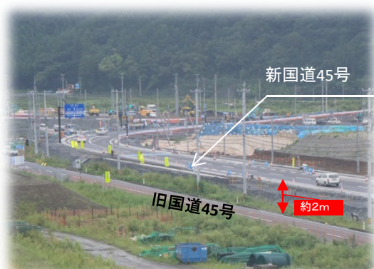
▲2m程かさ上げされた新国道
