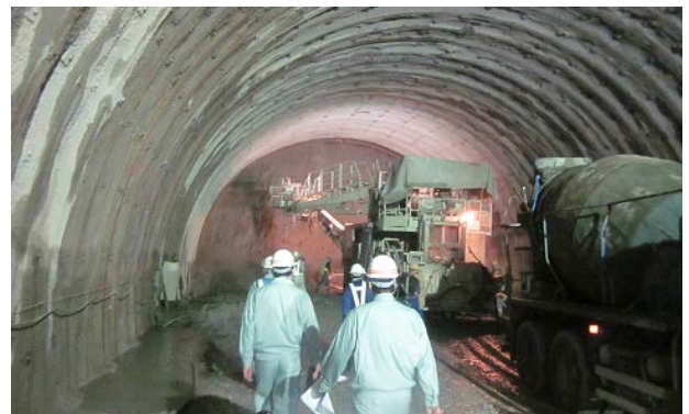
（仮称）新箱石トンネル切羽を見学
