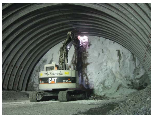
トンネル貫通の瞬間
