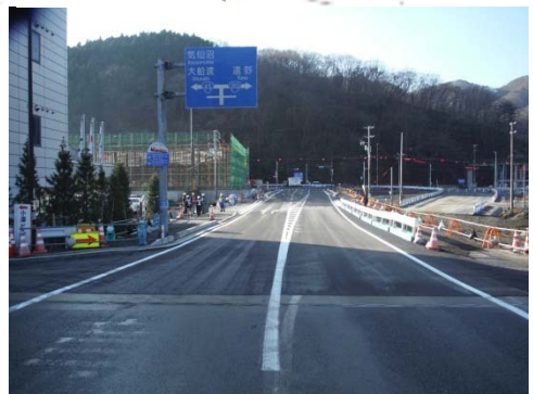
平成27年12月13日供用のかさ上げされた国道45号 →
