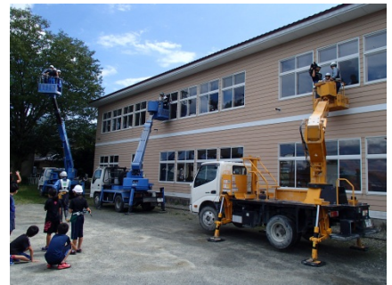
高所作業車で2階の窓へ
