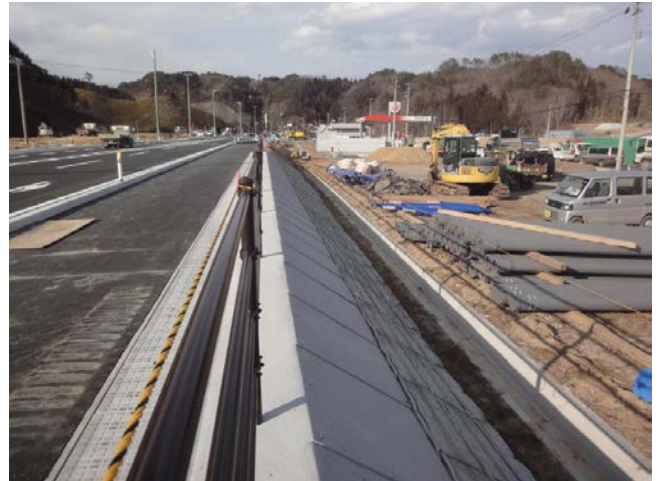
▲かさ上げされた国道45号
