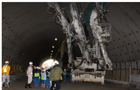
▲トンネル工事の大型機械に大興奮! (11月28日 山田北小学校 山田第1トンネル見学)
