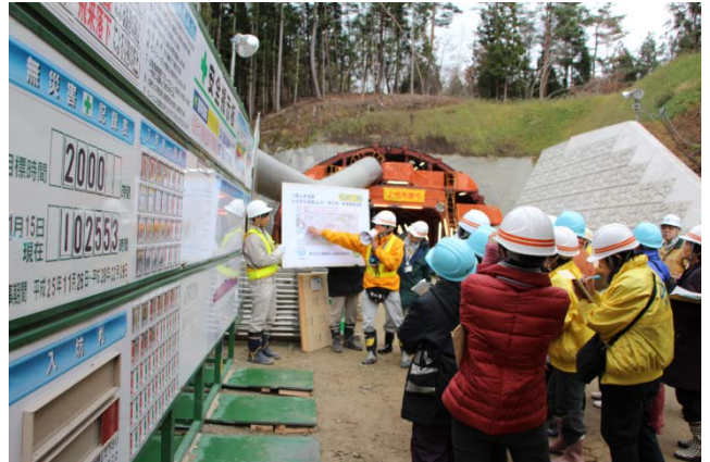
▲山田第2トンネル北側坑口
