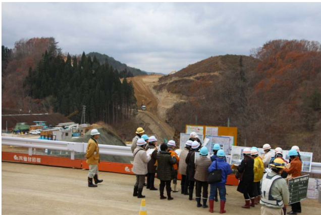
▲千徳小山田道路工事現場（宮古中央IC付近）
