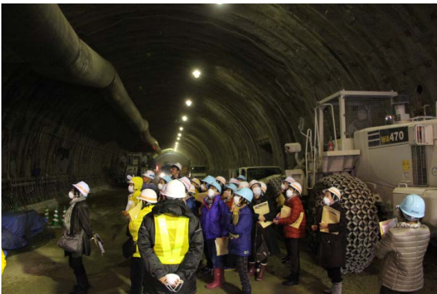
▲山田第2トンネル内部
