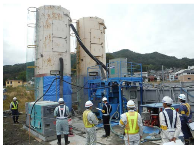
▲現場で改善すべき点などを点検
