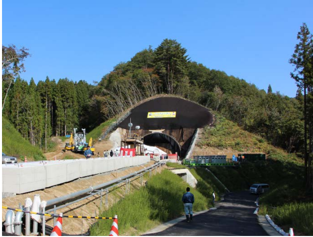
▲安全祈願祭の式典会場 山口第2トンネル南側坑口
