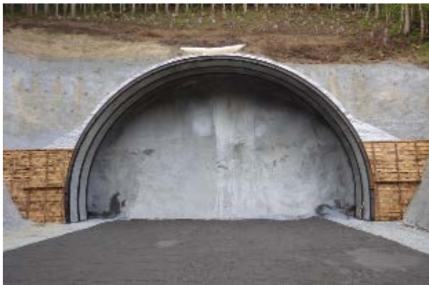
▲小本トンネル起点側（南側）坑口 ここから本格的に掘削工事が始まります
