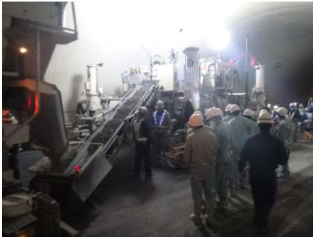
▲コンクリート舗装工事を間近で見学
