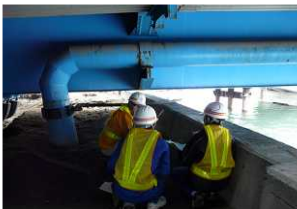
宮古大橋の下を点検中
