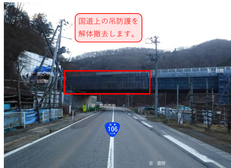
【施工箇所写真】
