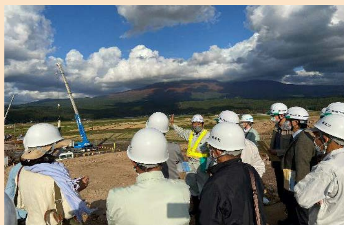
遊佐鳥海IC付近の盛土箇所から高架橋の施工を見学
