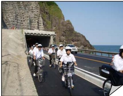
鱒ヶ崎トンネル拡幅工事は、歩行者と自転車の安全を図るため歩道部を拡幅し、車道部は国際コンテナ用セミトレーラの走行が可能な高さ・幅員を確保するため、平成16年度より事業着手し、この度完成したものです。
