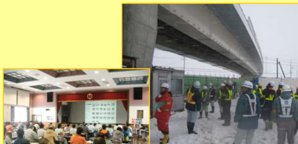
↑ 現場点検状況
