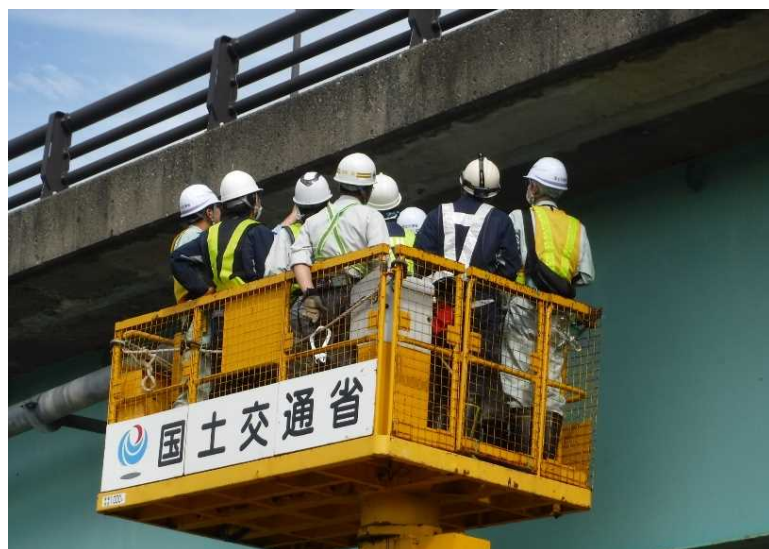
▲近接目視による点検を体験 (床版)
