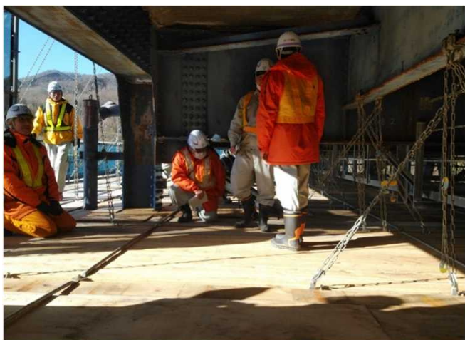
▲システム足場見学
