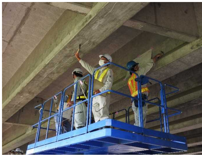
▲R2高所作業車による 近接打音確認
