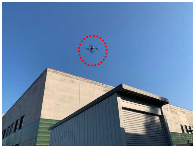
▲ドローンによる屋根・壁面の点検状況及び撮影画像
