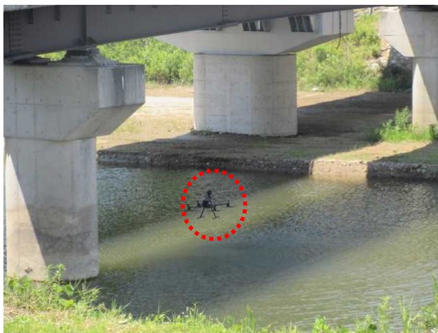
▲ドローン撮影による橋梁床版等の変状等の調査状況
