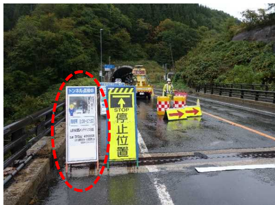
▲トンネル点検看板設置の状況
