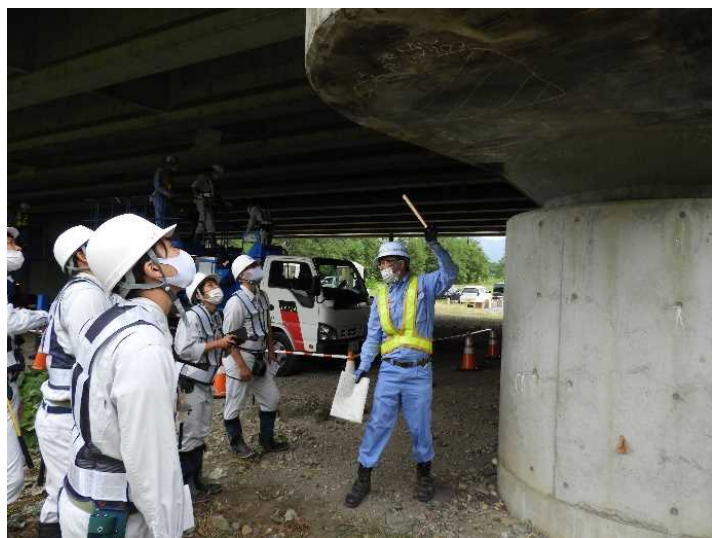
▲R2現地研修状況 短大生による近接打音確認
