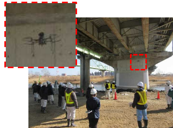
▲過去の橋梁点検支援技術講習会の様子
